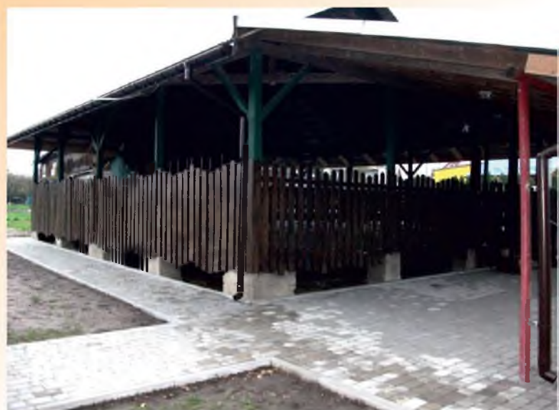
„Orynnowanie grzybka, odprowadzenie wody deszczowej, ułożenie kostki wokół altany”
