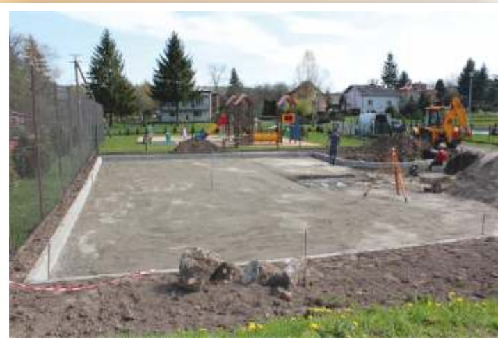
Prace przy budowie placu manewrowego przy Zespole Szkół w Pawłosiu
