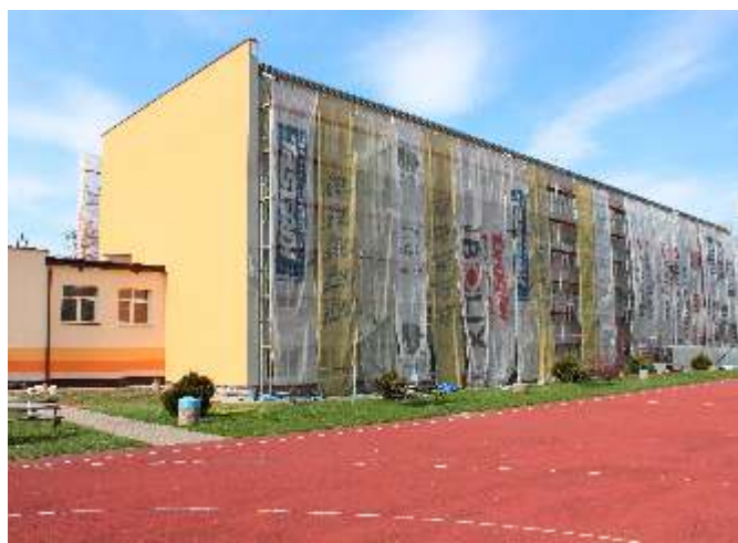
Termomodernizacja Zespołu Szkół w Pawłosiu
